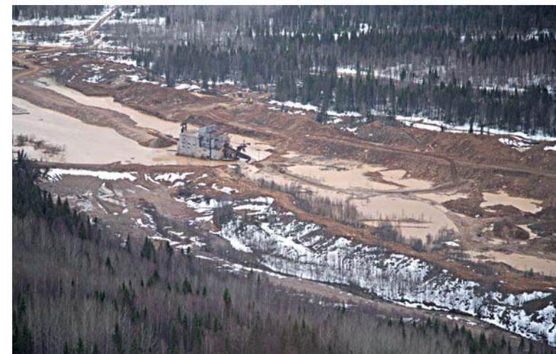
**Рис. 2.12.** Драга «Уралалмаз» на р. Большой Колчим (фото из архива ГИС центра ПГНИУ)
